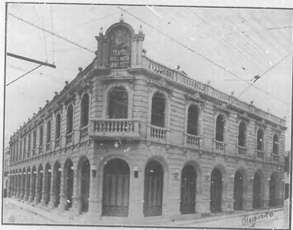
CAMAGÜEY. Teatro Avellaneda, inaugurado recientemente.
